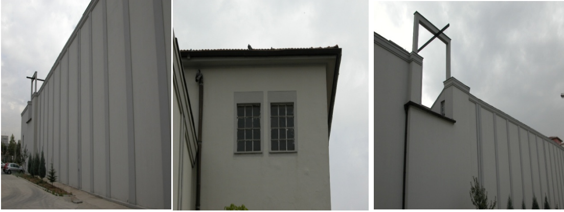
Ana bina genel görünüm (kaynak: Bilge İmamoğlu arşivi))
