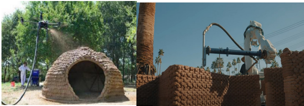
Görsel 4. Bio-püskürtme yöntemi (a) (Samec, vd., 2019) ve 3D baskı teknolojisi ile toprak duvar üretimi (b) (URL6)
