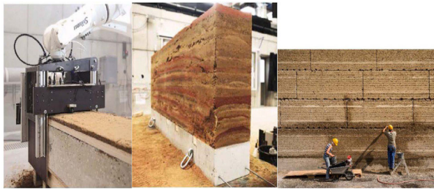
Görsel 3. Robotik sistemler ile sıkıştırılmış toprak üretimi (Gomaa, vd., 2023)
