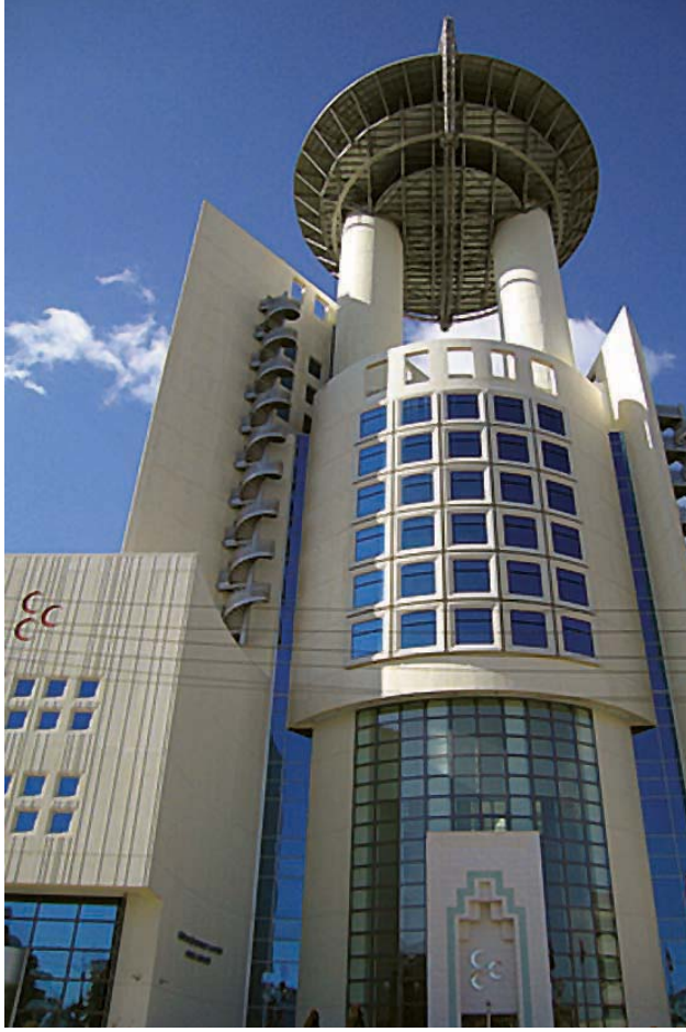
Resim 2. MHP-Selçuklu Taç Kapı ve Üç Blok.
