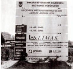
Fotoğrafta görülen inşaat alanı, Keçiören metrosu için hazırlanan bir bölgedir. Keçiören metrosu tamamlandığında Ankara, rahat ve hızlı ulaşımın şehri haline gelecek.
