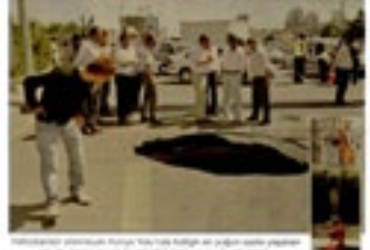
Altıncıdaki toprak çökmesi Kızılay-Cayıyolu metro inşaatının çökmesiyle birlikte gündeme geldi.
