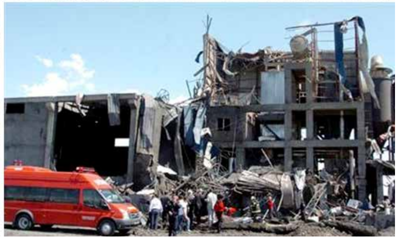
Resim 1. Kahramanmaraş'ta bir kot boyama fabrikasında meydana gelen patlama sonucu (13 Nisan 2012) binanın neredeyse üçte ikisi göçerken patlama ve çökme sonucu 4 işçi yaşamını yitirmiştir. Resim kaynakları: www.hurriyet.com.tr ; http://www.ntvmsnbc.com ; http://www.stargazete.com
