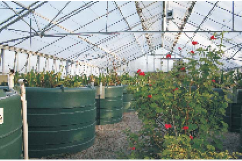
Resim8 Findhorn Ekoköyü biyolojik arıtma sistemi. Tamamen pasif olan sistemde siyah su arıtılarak sulama suyu elde ediliyor. (Fotoğraf: Z. Ebru Aksoy)
