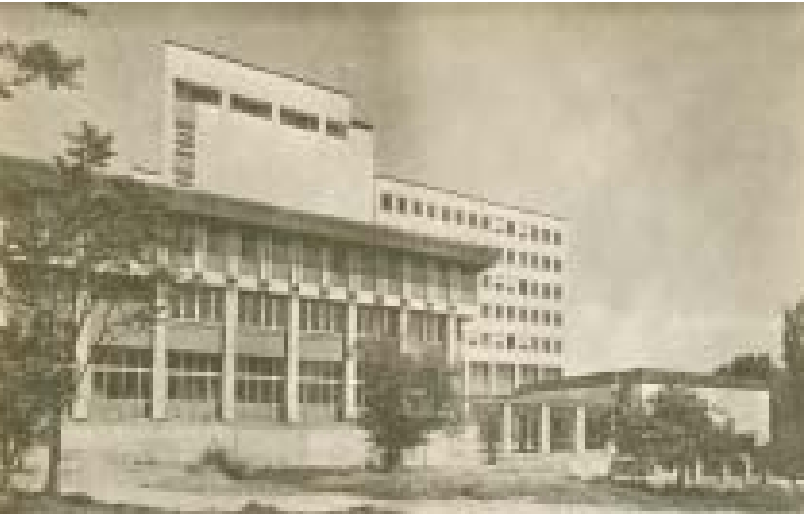
Yapının Güney Cephesi (Mimarlık, 1976, 4)
