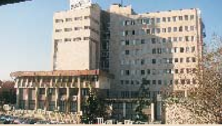
Güney Cephесinin Şimdiki Durumu
