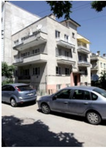
Resim 2: Yapının Ön ve Yan Cephesi
