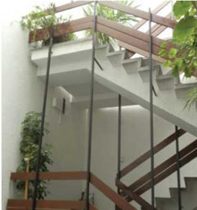
Resim 7 Galeri boşluğundaki metal profiller
