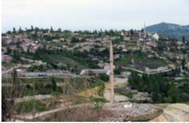
Kuzey Ankara Projesi Gecekondu Yıkımlarının Ardından
